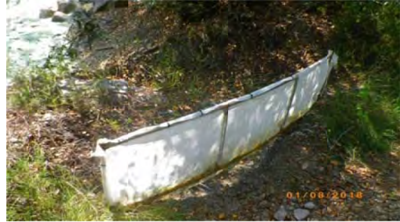
Foto 18: Punto de Vertido PV-01. Actualmente ausencia de vertido procedente de la Balsa 2. Barrera de filtración en boca de salida
