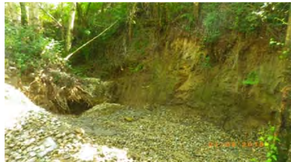
Foto 14: Aplicación de tratamiento en zona de agua de surgencia, a 70 m. aguas arriba de la Balsa 2.
