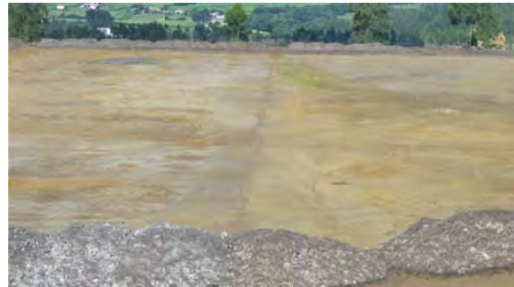
Foto 4: Presencia de pequeños canales para derivación del agua de escorrentía en la Zona 3.
