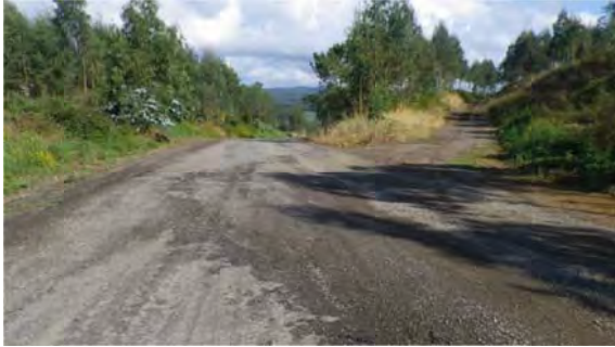
Foto 9: Derivación de las aguas de escorrentía en la Zona 6, al margen del viario existente.
