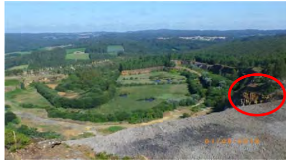
Foto 6: Punto de aporte de las aguas desde la Zona 3 a la Balsa 1. Vista de la Balsa 1
